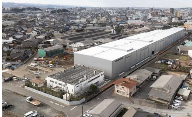
渡部製鋼所本社 出雲工場
