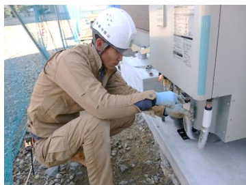
エコキュート設置作業の様子
