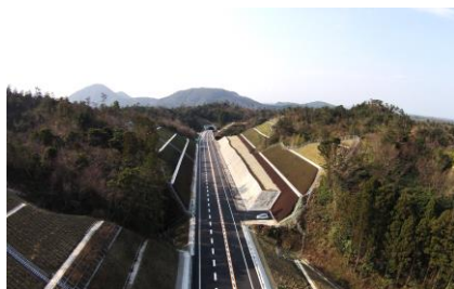
仁摩温泉津道路馬路地区改良第6工事
