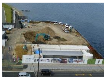
大橋川天神川水門新設1期工事
