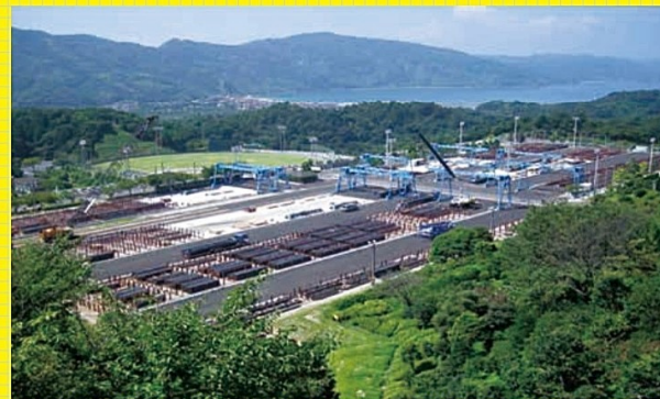
原子力発電所建設のために、特別に設置した鉄筋加工場。門型クレーン10基が並ぶ。
