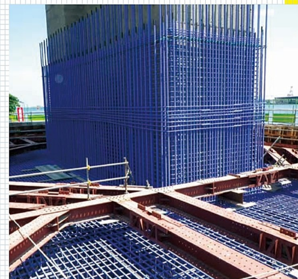
橋脚耐震補強工事 (フーチング・柱)
