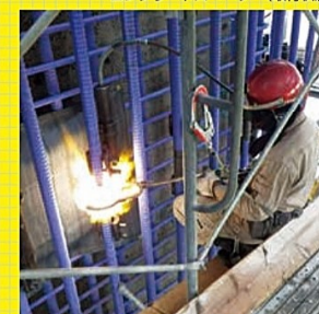
ガス圧接継手
