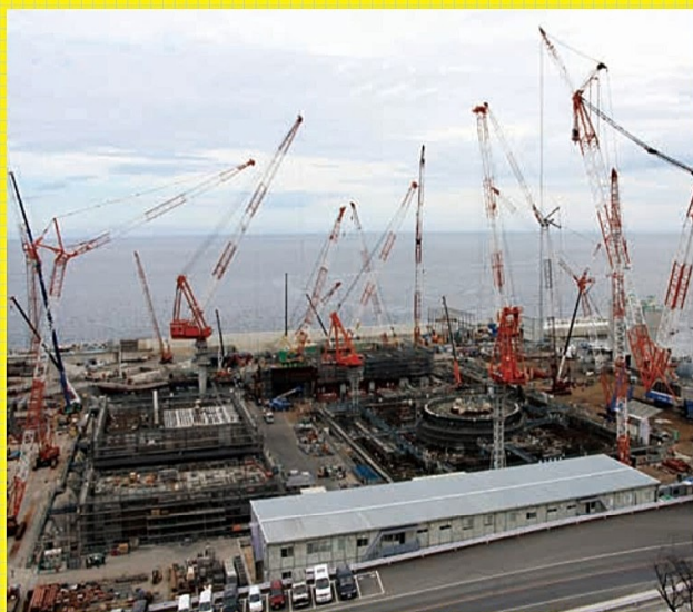
中央マットモジュール(吊り込み状況)
