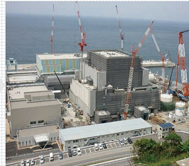
島根原子力発電所3号機関連工事(平成20年度)
