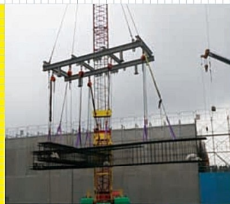
梁地組工法 (吊り込み状況)
