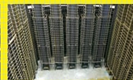
橋脚(3H工法)
