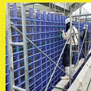
ビニール被覆結束線 (結束状況)
