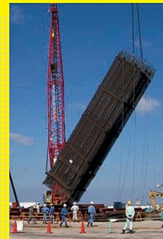
柱地組工法(吊り込み状況)
