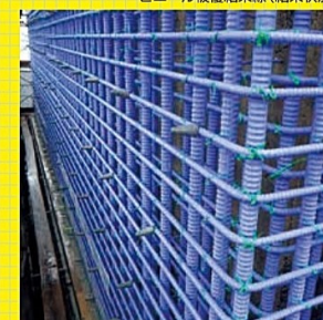
コンクリートスペーサー (取付状況)
