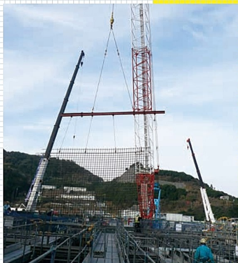
壁ユニット工法 (吊り込み状況)
