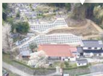
地すべり対策の法枠施工後
