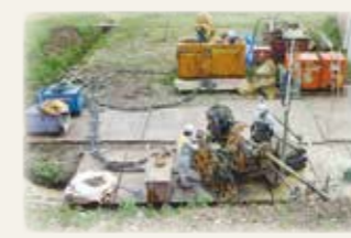
パーカッションドリルでの削孔
