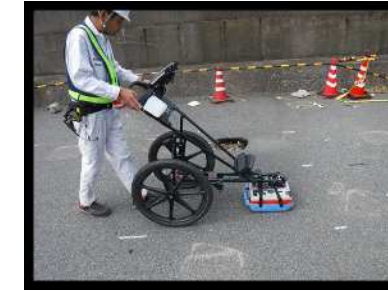
地中埋設物調査
