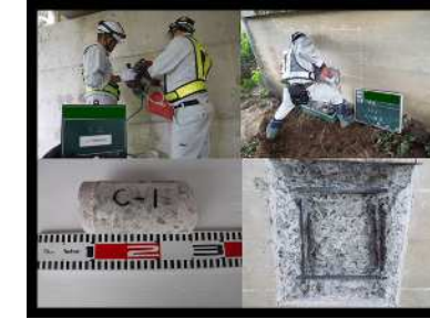
コンクリート調査
