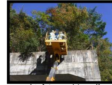
トンネル・ロックシェッド・ カルバート点検
