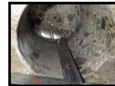
PCグラウト充填状況調査
