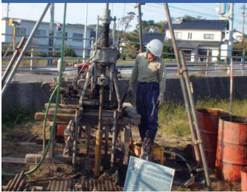
調査ボーリング実施状況
